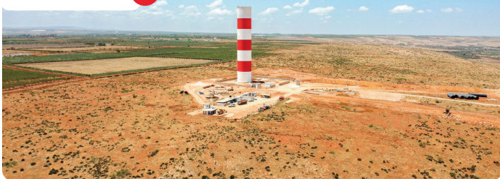
Aménagement hydroagricole de la plaine de Saïss 2021-2024 ☆
